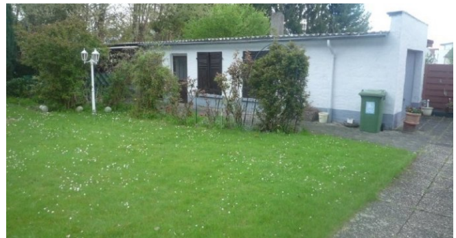
garage m negebäude
